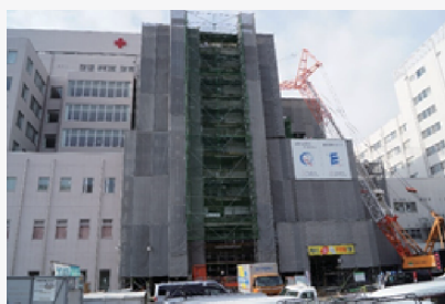
正面玄関付近の建築状況
