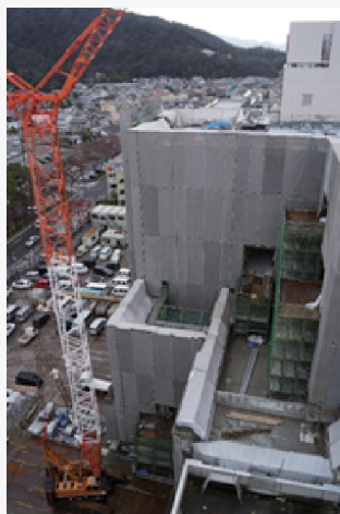
外部足場を解体しています
