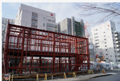
敷地内薬局の鉄骨建方
